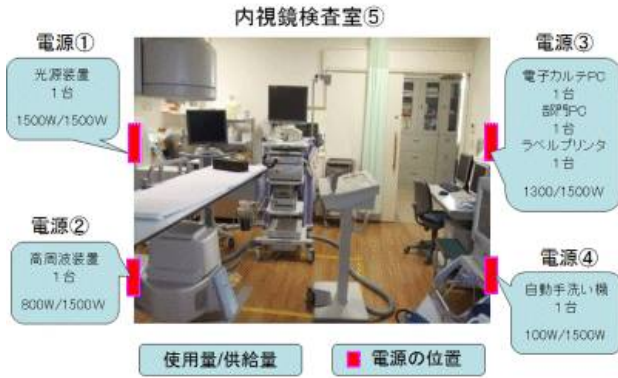
(図3) 検査室の配線の確認と調整
