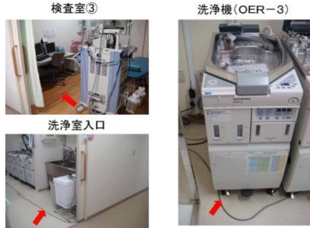
(図4) 洗浄室の配線の確認と調整
